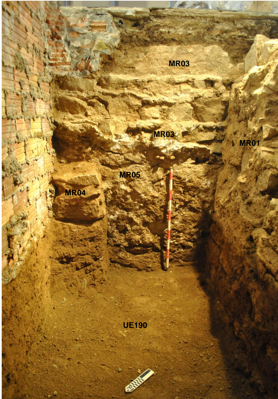
Interrelació dels murs MR01, MR03, MR04 i MR05 a la banda oriental del mur MR01, vist des del Nord.
