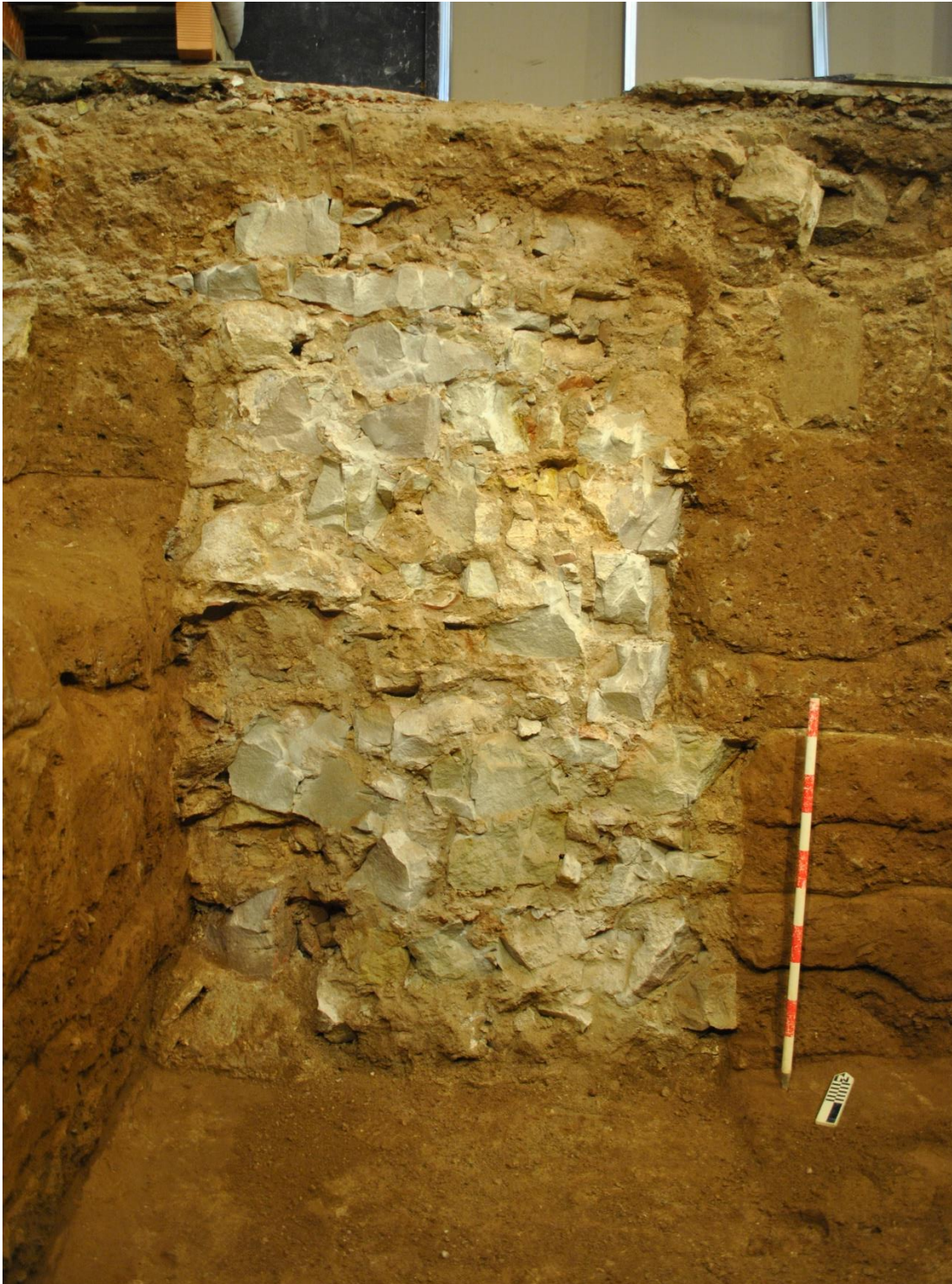
Secció del mur MR01 després de la seva destrucció. A la part inferior dreta s'observa el recreixement de la fonamentació per a instal·lar la cisterna CS01.
