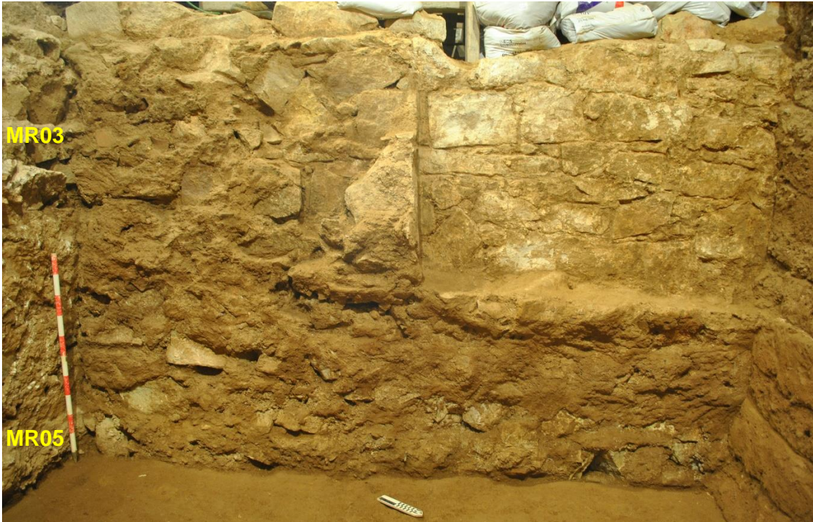
Cara oriental del mur MR01. S'observa clarament l'encaix solidari de la cisterna al seu fonament i el reforç de la filtració al centre. A l'esquerra, el mur MR05
