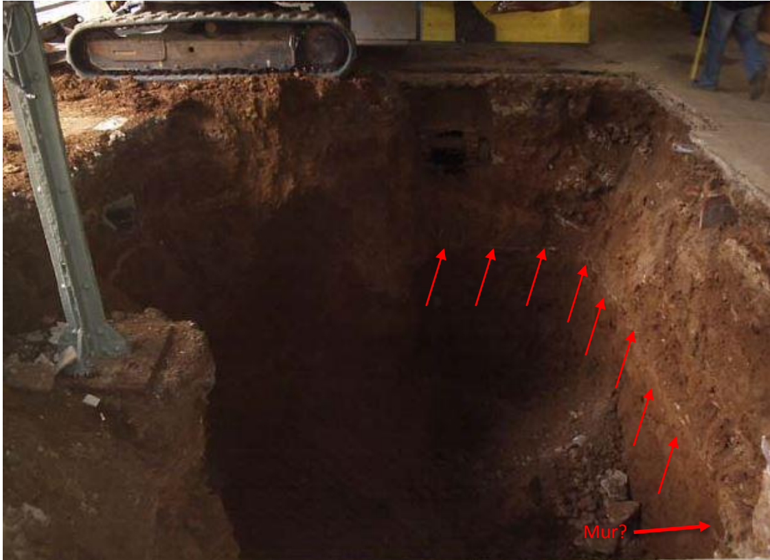
Imatge de la intervenció a la Parada 145 [...] 182. Al tall estratigràfic es pot apreciar una fina línia de color blanc que podria correspondre a l'enlluït de calç hidrofugant de la cisterna CS01. A la cantonada inferior dreta, s'observen les restes d'un possible mur. (Foto: ATICS, SL)
